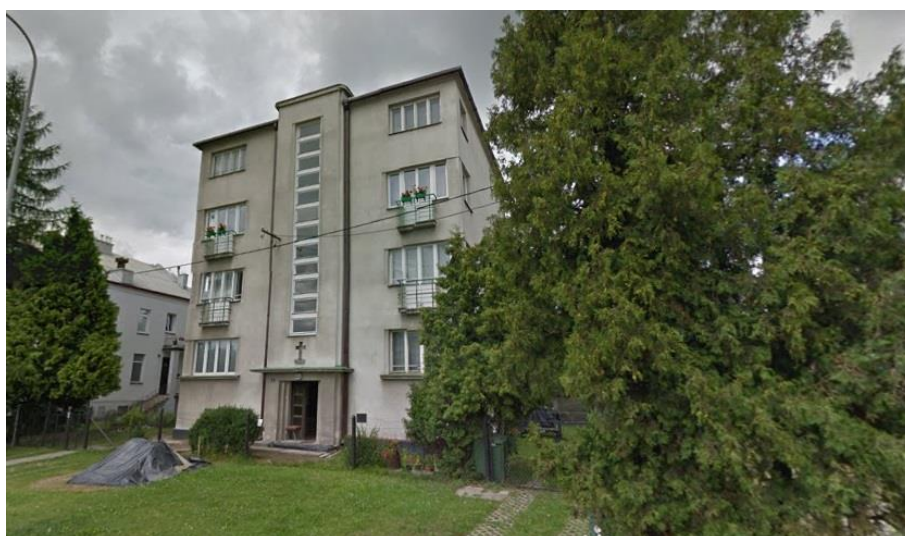
Fotografia 12 Zabytkowa kamienica przy ul. Wyspiańskiego 6 (odległość 134 m od inwestycji)
