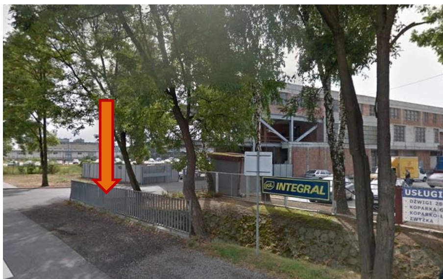
Fotografia 2 Widok na miejsce, gdzie potok Mikośka w stanie obecnym wpływa w kanał pod ulicę Langiewicza (na południe od planowanego zaplecza)
