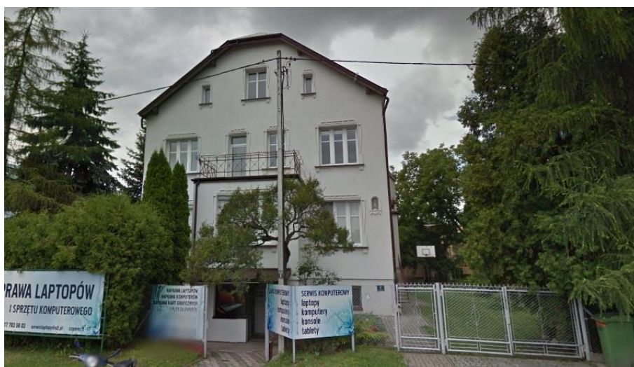
Fotografia 11 Zabytkowa kamienica przy ul. Wyspiańskiego 8 (odległość 111 m od inwestycji)
