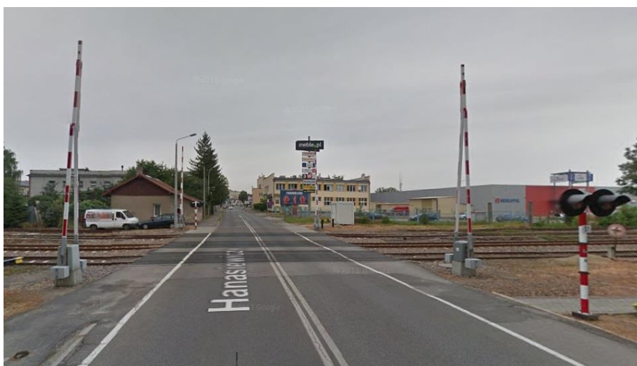
Fotografia 15 Przejazd w ciągu ulicy Hanasiewicza (stan istniejący)
