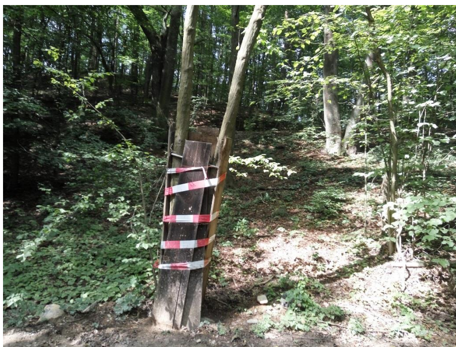
Fotografia 3 Przykład zabezpieczenia drzewa osłonami (droga ekspresowa S7 Miłomłyn – Olsztynek)
